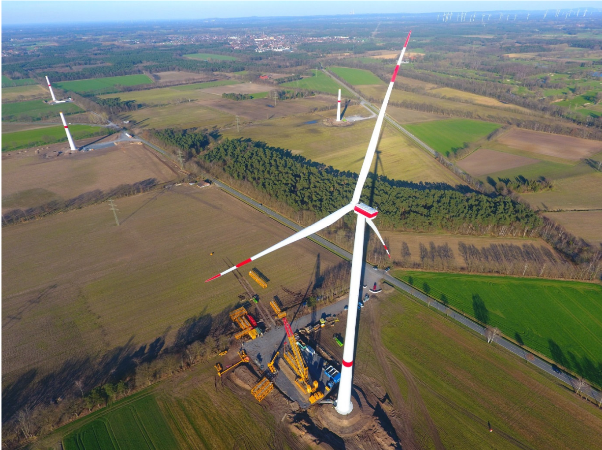
Bild aus der Bauphase im Frühjahr 2017
